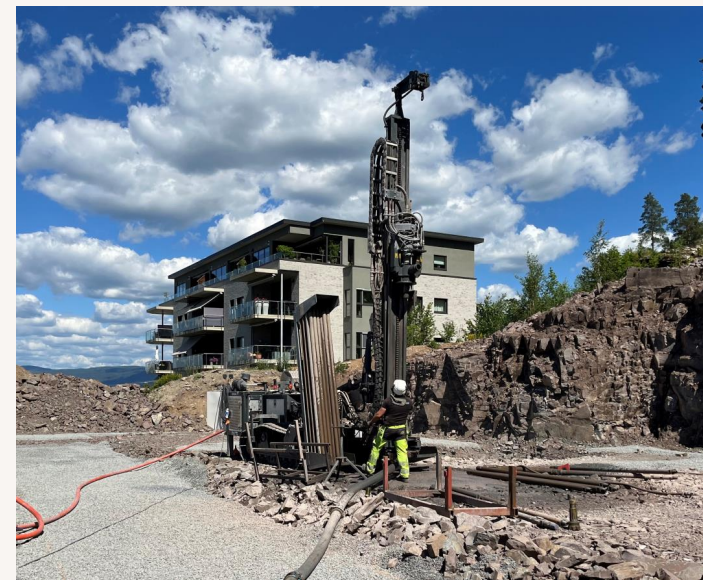
Dypere energibrønner for 30 leiligheter i boligprosjekt i Hole kommune
